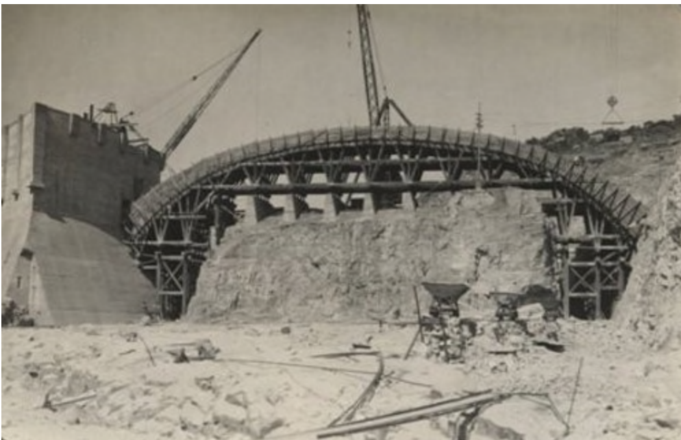
Bou van die brug oor die uitloop.
