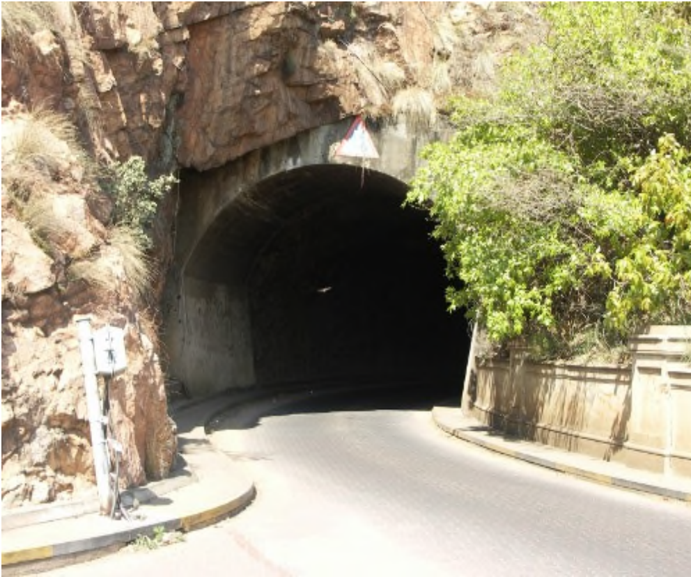
Die tonnel aan die ooste kant van die Dam.
